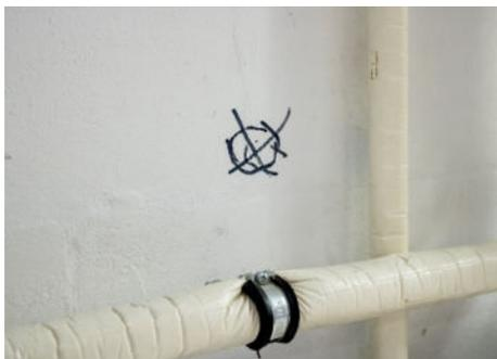
③ Die Stelle der Hauseinführung im Keller bzw. Hausanschlussraum, an welche das Glasfaserkabel später in Ihr Haus gelangt, wird vor der Bohrung genau markiert.
