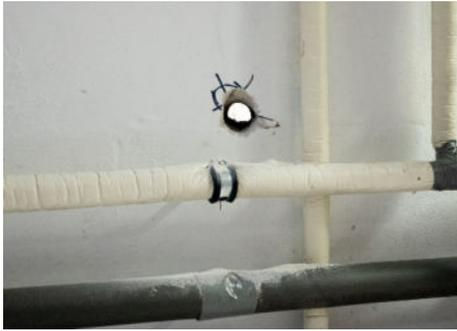
5 Das Loch für die Hauseinführung ist wenige Millimeter (ca. 16 mm Durchbruchbohrung) groß und wird nach Beendigung der Arbeiten wieder gas- und wasserdicht verschlossen.
