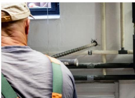
④ Damit das Glasfaserkabel ins Haus gelangen kann, bohren wir ein kleines Loch in Ihre Hauswand (straßenseitige Außenwand). In dieses wird ein 10 mm dickes Kunststoffröhrchen zur Aufnahme des Glasfaserkabels gesteckt und danach die Bohrstelle fachgerecht verschlossen und abdichtet.
