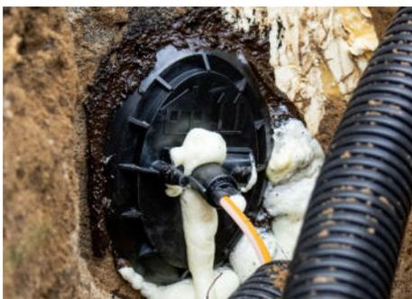
9 Der Kunststoffflansch für die Glasfaserhauseinführung wird mit Bitumen-Dickbeschichtung und Silikonschaum abdichtet.
