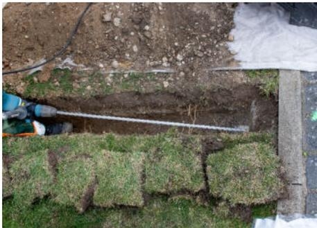
12 Zum Gehwegbereich erfolgt bereits die Bohrung der Zuführung für die spätere Abzweigung des Glasfaserkabels zu Ihrem Grundstück.
