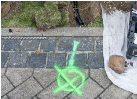
11 Neben dem Hausanschluss müssen die Glasfaserkabel auch in den öffentlichen Wegen bzw. im Gehwegbereich verlegt werden. Dies erfolgt im Zuge des Ausbaus der öffentlichen Trassen. Für die spätere Zuführung zu Ihrem Grundstück wird an der Grundstücksgrenze der Zuführungsbereich markiert.
