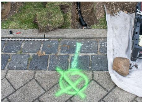
11 Neben dem Hausanschluss müssen die Glasfaserkabel auch in den öffentlichen Wegen bzw. im Gehwegbereich verlegt werden. Dies erfolgt im Zuge des Ausbaus der öffentlichen Trassen. Für die spätere Zuführung zu Ihrem Grundstück wird an der Grundstücksgrenze der Zuführungsbereich markiert.
