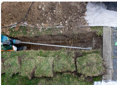
12 Zum Gehwegbereich erfolgt bereits die Bohrung der Zuführung für die spätere Abzweigung des Glasfaserkabels zu Ihrem Grundstück.
