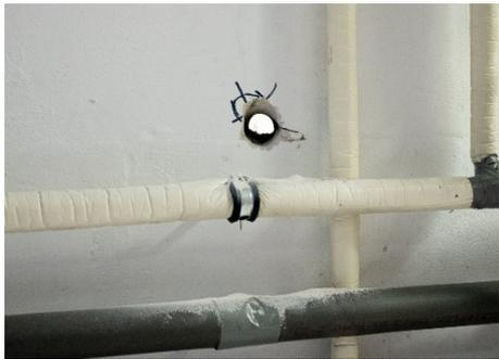
**5** Das Loch für die Hauseinführung ist wenige Millimeter (ca. 16 mm Durchbruchbohrung) groß und wird nach Beendigung der Arbeiten wieder gas- und wasserdicht verschlossen.
