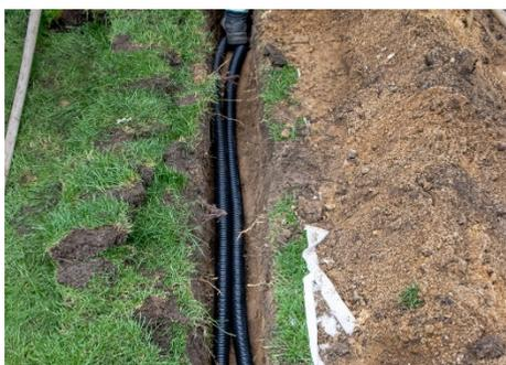
**8** Die Leitungen werden in Schutzrohre gelegt, um sie vor Beschädigungen zu schützen und den Zugriff für zukünftige Reparaturen oder Erweiterungen zu erleichtern.
