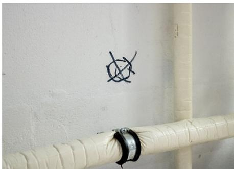
3 Die Stelle der Hauseinführung im Keller bzw. Hausanschlussraum, an welche das Glasfaserkabel später in Ihr Haus gelangt, wird vor der Bohrung genau markiert.
