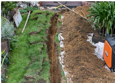
**6** In den offenen Graben wird das Leerrohr, das sogenannte Micropipe-Leerrohr, gelegt. In dieses wird später das Glasfaserkabel eingeblasen.
