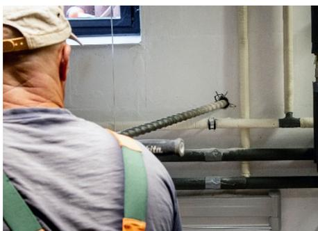
4 Damit das Glasfaserkabel ins Haus gelangen kann, bohren wir ein kleines Loch in Ihre Hauswand (straßenseitige Außenwand). In dieses wird ein 10 mm dickes Kunststoffröhrchen zur Aufnahme des Glasfaserkabels gesteckt und danach die Bohrstelle fachgerecht verschlossen und abdichtet.
